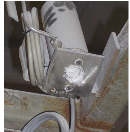
Figur 3. Processpyrometrar utsätts ofta för smutsig och het omgivning. Med lämpliga tillbehör minskar man riskerna för mätfel och minimerar underhållskostnaderna.
